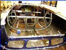
Colocando mamparos estructurales
