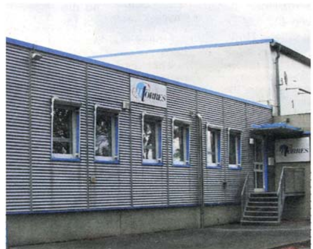
Die MTorres-Zentrale in Stade liegt nicht ohne Grund in unmittelbarer Nähe zum Stader Airbus-Werk. Foto: Schindler
